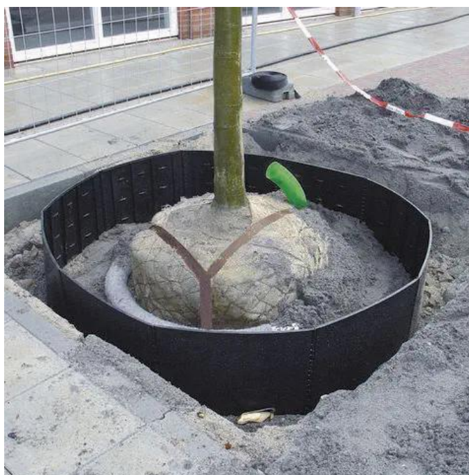
Figura 5. Exemplo de aplicação de Paineis anti raízes. Fonte: https://www.archiexpo.com/pt/prod/greenmax/product-92582-1802884.html
