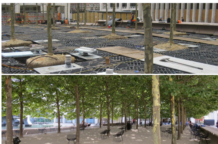
Figura 3. Exemplo de aplicação (fase de obra e estado atual) de “Soil Cells” na Praça do Lincoln Center (Nova Iorque)
