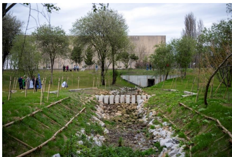
Figura 7. Exemplo de aplicação de técnicas combinadas, com enrocamento das margens, gradeamento com vegetação, plantações arbóreas e arbustivas e hidrossementeira, associadas à criação de um atravessamento (“poldras”) com funções simultaneamente recreativas e de diminuição dos caudais de ponta . Parque da Asprela (Porto).
