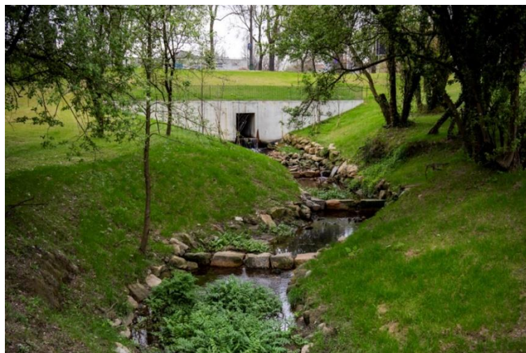
Figura 8. Exemplo de aplicação de enrocamento e defletores de corrente (pequenos açudes em pedra), no leito da linha de água, com hidrossementeira para estabilização de margens. Parque da Asprela (Porto).
