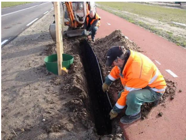
Figura 4. Exemplo de aplicação de Tela anti raízes, entre trincheira de plantação e pavimento Fonte: https://www.archiexpo.com/pt/prod/greenmax/product-92582-1802884.html
