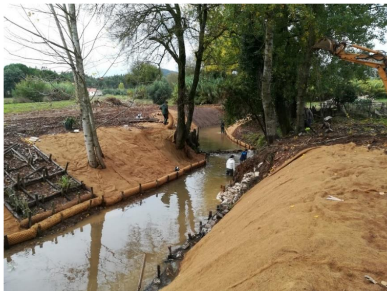
Figura 6. Exemplo de aplicação combinada de manta orgânica, bio-roló, gabião cilíndrico, entrançado e faxina viva, estacaria viva e hidrossementeira. Ribeira da Gançaria (concelho de Santarém).
