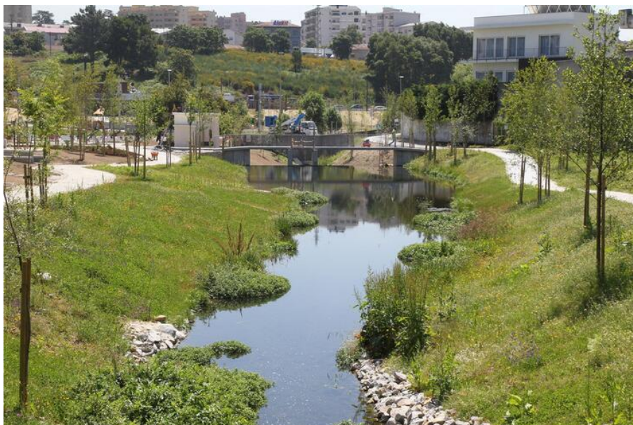
Figura 11. Requalificação da Ribeira da Castanheira, com a criação do Parque Urbano de Rio Tinto (Gondomar), implementando-se uma bacia de retenção que auxilia na diminuição dos eventos de cheias registadas a jusante.
