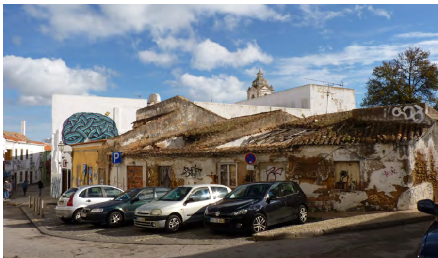
Ilustração 7. Edifícios na Rua Lançarote de Freitas
