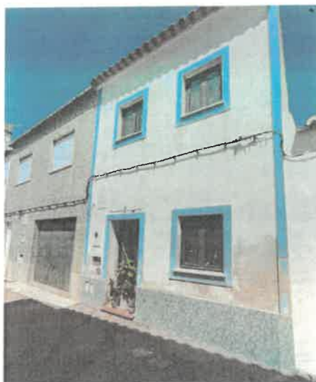
Legenda: Fachada na Rua de Santo António
